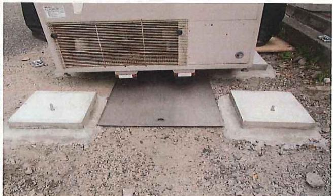
⑨ レベリングは小石板の貫通穴に通したM1.2寸切ボルトで強化カギ型固定金具を使用して共締め固定する。
