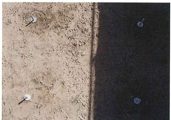
⑦ 土の表面は一般的に凸凹があり、かつ水平面でない為、あらかじめ土の表面を水平にならし、かつ、小石板面積より少し大きめにモルタルを厚み20 mm位を目安に打設し、小石板をスクリューアンカーに取付けたM 1 6 寸切ボルトを貫通穴に通す。
