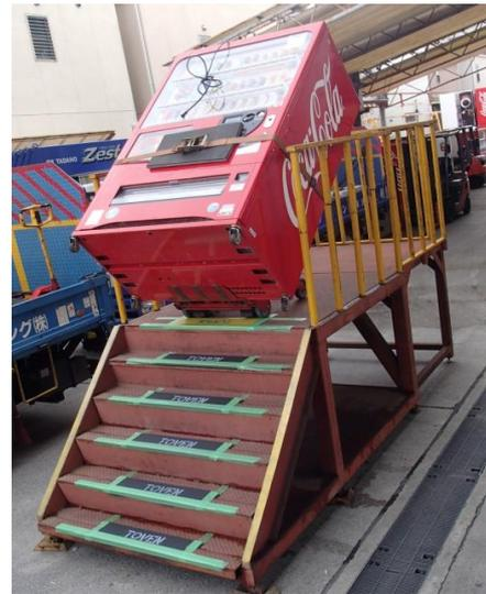
写真は鉄骨縞鋼板仕様の階段であるが、一般的にはコンクリートの上にPタイル他樹脂系の材料で表面を施工している。そして、ノンスリップが施されておりこれも金属系・樹脂系その他が使用され、取付方法もねじ又は接着の様である。更に建物の老朽によるノンスリップ取付部分の劣化で外れやすくなっているケースが比較的多い事を認識し、現場でしっかり手で触って確認をすることが重要である。
