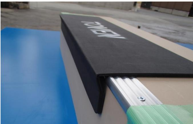
アクリル変性高衝撃塩ビ板をL型に加工し、ノンスリップ養生として写真の様に取付。養生テープで補強する。
